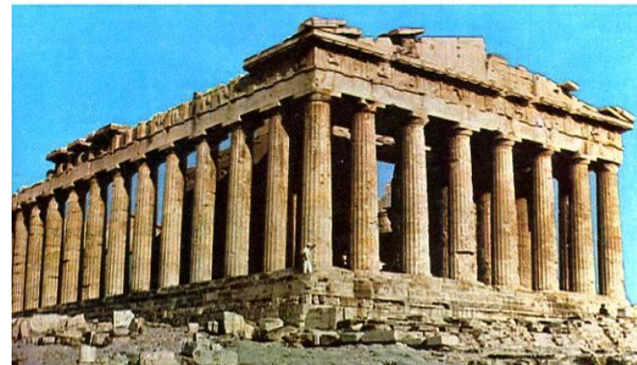
Partenone, VI sec A.C. Sistema trilitico
